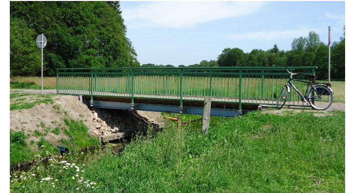
Die neue Brücke über die Haaren im Wold
